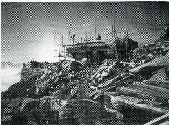
Il rifugio durante i lavori di ricostruzione.
